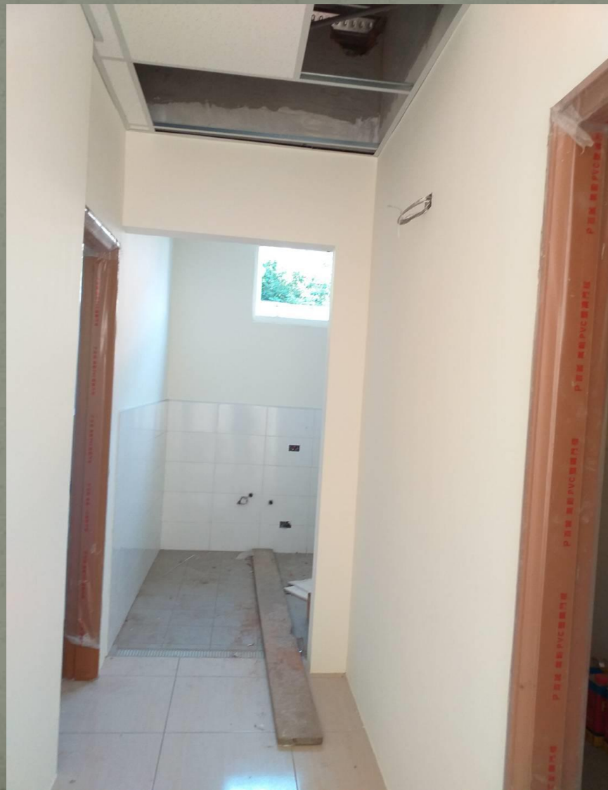
圖二十一 二樓男女廁所
