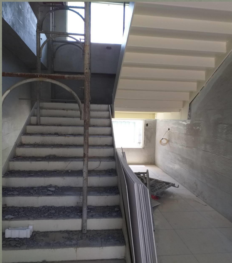
圖十一 一樓樓梯
