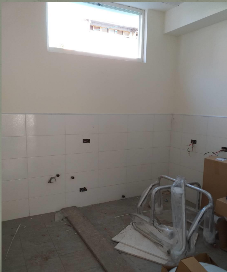
圖二十 一樓無障礙廁所
